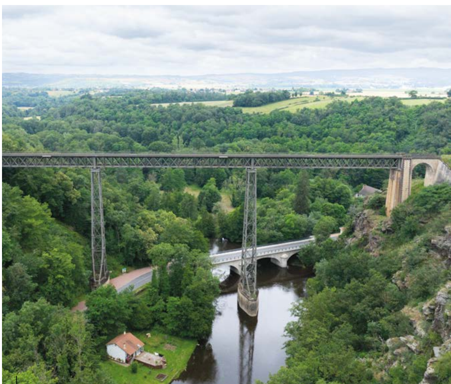
Viaduc de Rouzat, Saint-Bonnet-de-Rochefort
